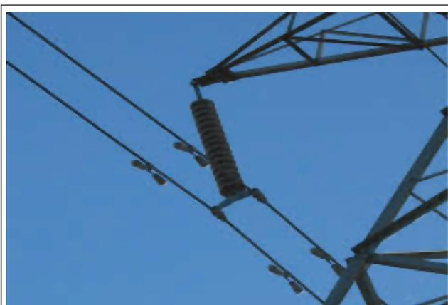
FIG. 2B ONLINE VIEW OF VIBRATION DAMPER IN OVER TRANSMISSION LINES
