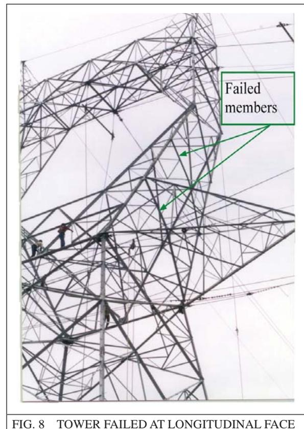
FIG. 8 TOWER FAILED AT LONGITUDINAL FACE
